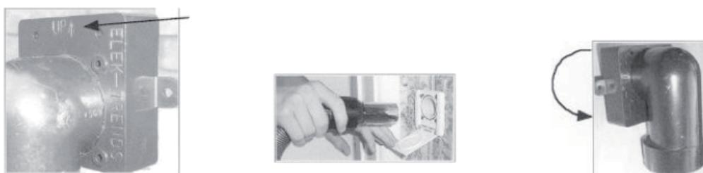
Il est toutefois plus facile d'insérer l'extrémité du flexible dans une prise d'aspiration que s'ouvre vers le bas (image ci-dessus) de manière à ce que l'orifice de la prise apparaisse dès l'ouverture de l'enjoliveur. Dans ce cas, les boîtiers raccords doivent être installés avec la flèche et la mention "UP" vers le bas, et non vers le haut. Si vous utilisez un boîtier raccord coudé 90°, faites tourner le boîtier à l'extrémité du tuyau si nécessaire (image en haut à droite).
